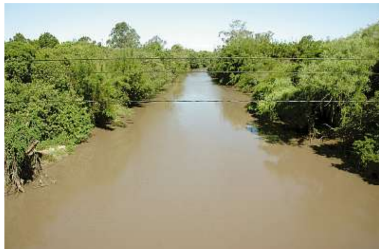
Técnicos entendem que trechos canalizados escoam rapidamente água da chuva
